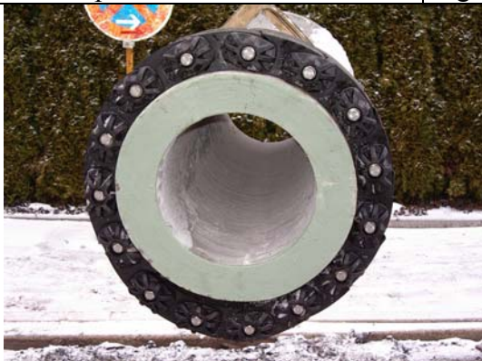
Подготовка звеньевго уплотнителя на трубе.
