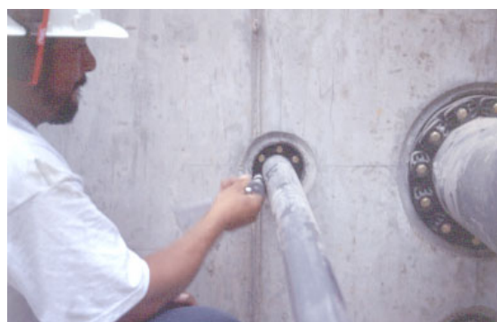
Монтаж звеньевго уплотнителя.
