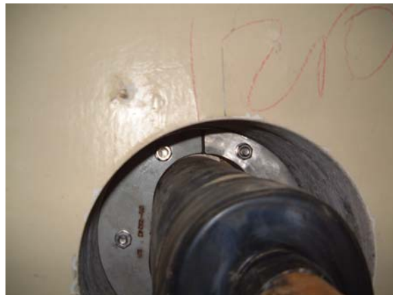
Специальное исполнение для овальных труб, резина особо мягкая для полимерных труб
