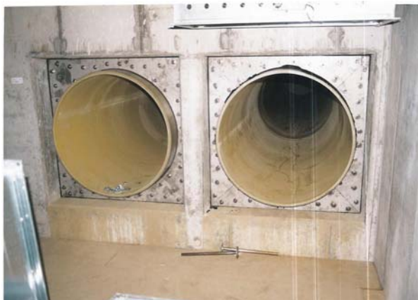
Специальное исполнение для трубы ДУ 1000 мм в квадратном проломе стены.
